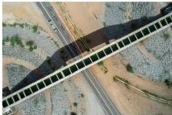
Aperfeiçoamento sobre BR 326 serve de canal para as águas captadas na represa de Itaipua
