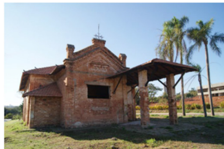
Prédio deve passar por duas fases de obras antes de passar a abrigar o MIS (Foto: Arquivo O Progresso)
